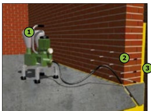
**1) Injektážní pumpa** InjektPump AG
