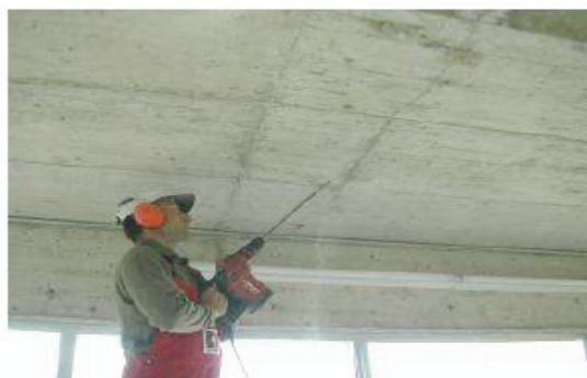
Obr. 2 Vrtání otvorů pro pakry
