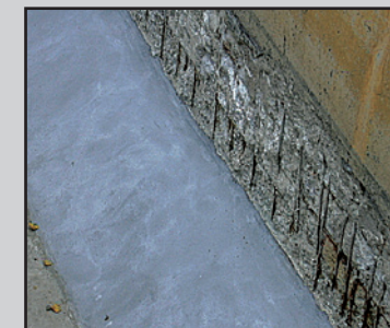
Reprofilace betonových konstrukcí
